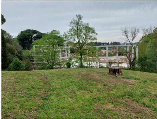
Vista del cantiere dal Parco
