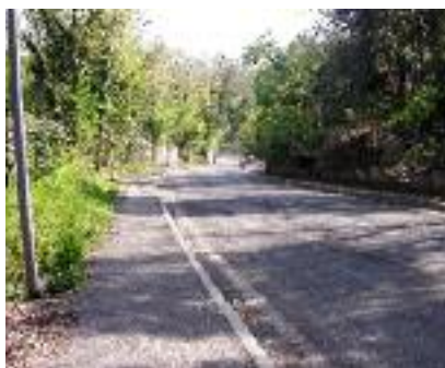
“Il Salitone” completamente riasfaltato.
