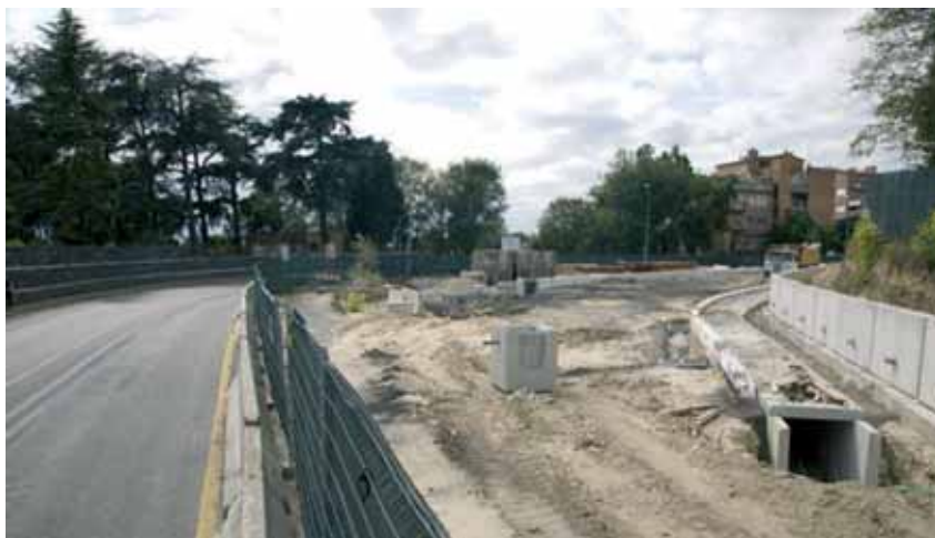
Una immagine dei lavori in corso lungo la "Trionfale".
