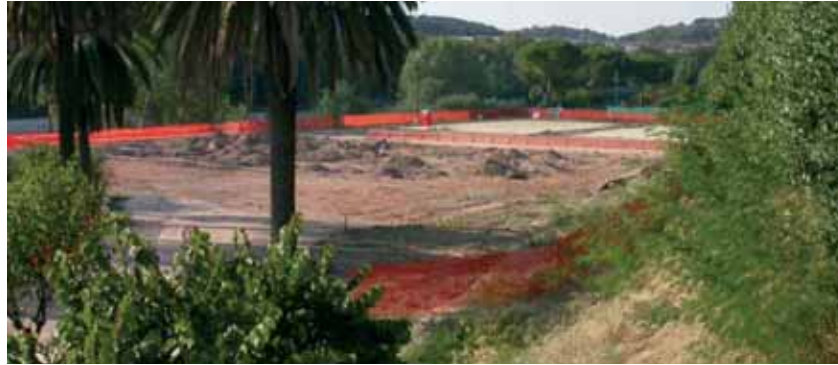
Una immagine (lato Flaminio) dell'inizio lavori per il nuovo ponte
