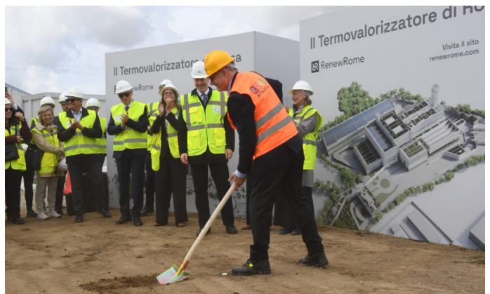
Il Sindaco Roberto Gualtieri ha iniziato i lavori il 15 maggio scorso! L'impianto viene presentato come "ultra sicuro, non inquinante, costantemente monitorato, tecnologicamente avanzato e costruito secondo standard ambientali più rigorosi di quelli previsti dalla normativa"; eliminerà costosi e inquinanti trasporti di questi materiali in altre zone d'Italia e all'estero.
